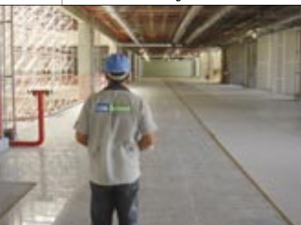
Inspeção visual do alinhamento e nivelamento do revestimento Visual inspection of the alignment and levelling the cladding
