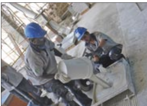
Preparação da argamassa Preparing the mortar
