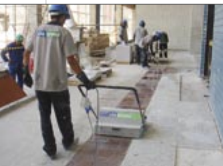
Aplicação do vibro-nivelador Using the vibration leveller
