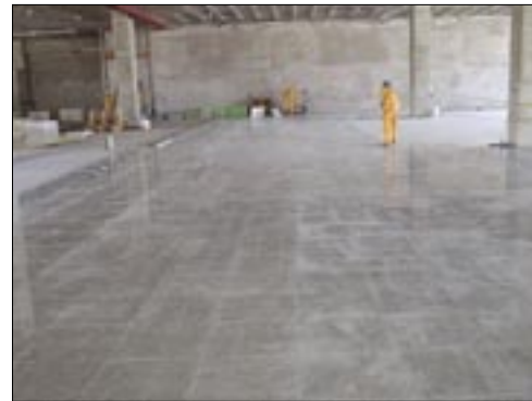
Vista do primeiro pano rejuntado
