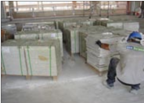
Inspeção do material a ser assentado Inspection of the material before grouting
