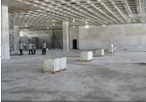
Verificação do contra-piso Checking the base
