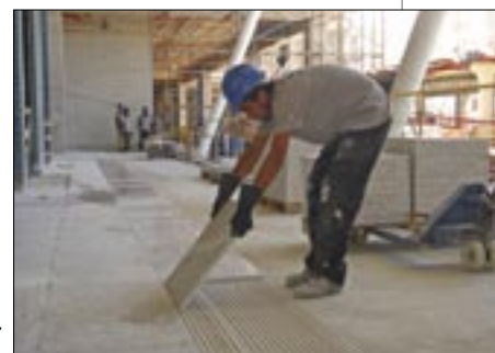
Assentamento e nivelamento dos ladrilhos de granito
